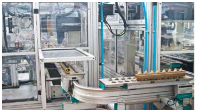
Dettaglio della catena completamente automatica di montaggio collettori. A detail of the manifolds' fully-automated assembly machine.
